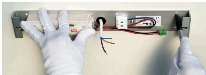
Hierbei auf Verlauf der Zuleitung in der Decke achten! Mindestens 3 Bohrungen  $\varnothing$  6 mm setzen und Dübel einsetzen. Grundplatte mit entsprechenden Schrauben an der Decke befestigen. Die Phase, Null-leiter und den gelbgrünen Erdleiter an der Lüsterklemme anschließen.
